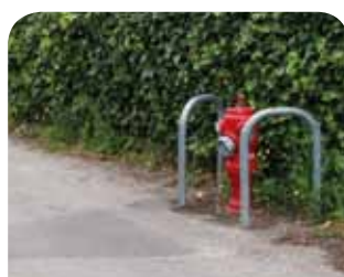
Mise en place d'un poteau à incendie.
