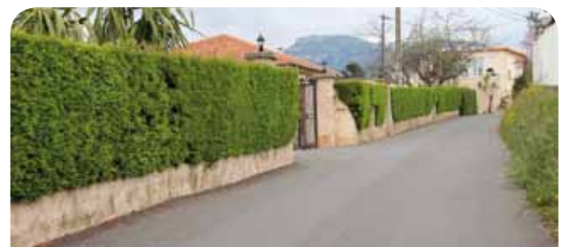
Rénovation de la conduite d'eau potable et réfection de la chaussée.
