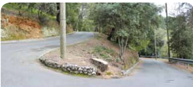
Débroussaillage et abattage des arbres dangereux le long du chemin.
