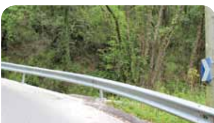
Mise en sécurité et cloutage du virage et installation d'une glissière de sécurité.
