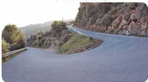
Le chemin Marcellin Allo : un nouvel enrobé a été réalisé afin de sécuriser la voirie
